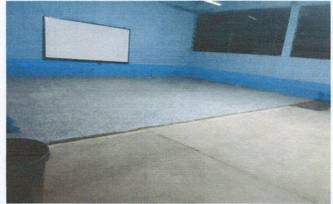
Foto 2: Área donde se esta instalando el piso cerámico Aula 3
